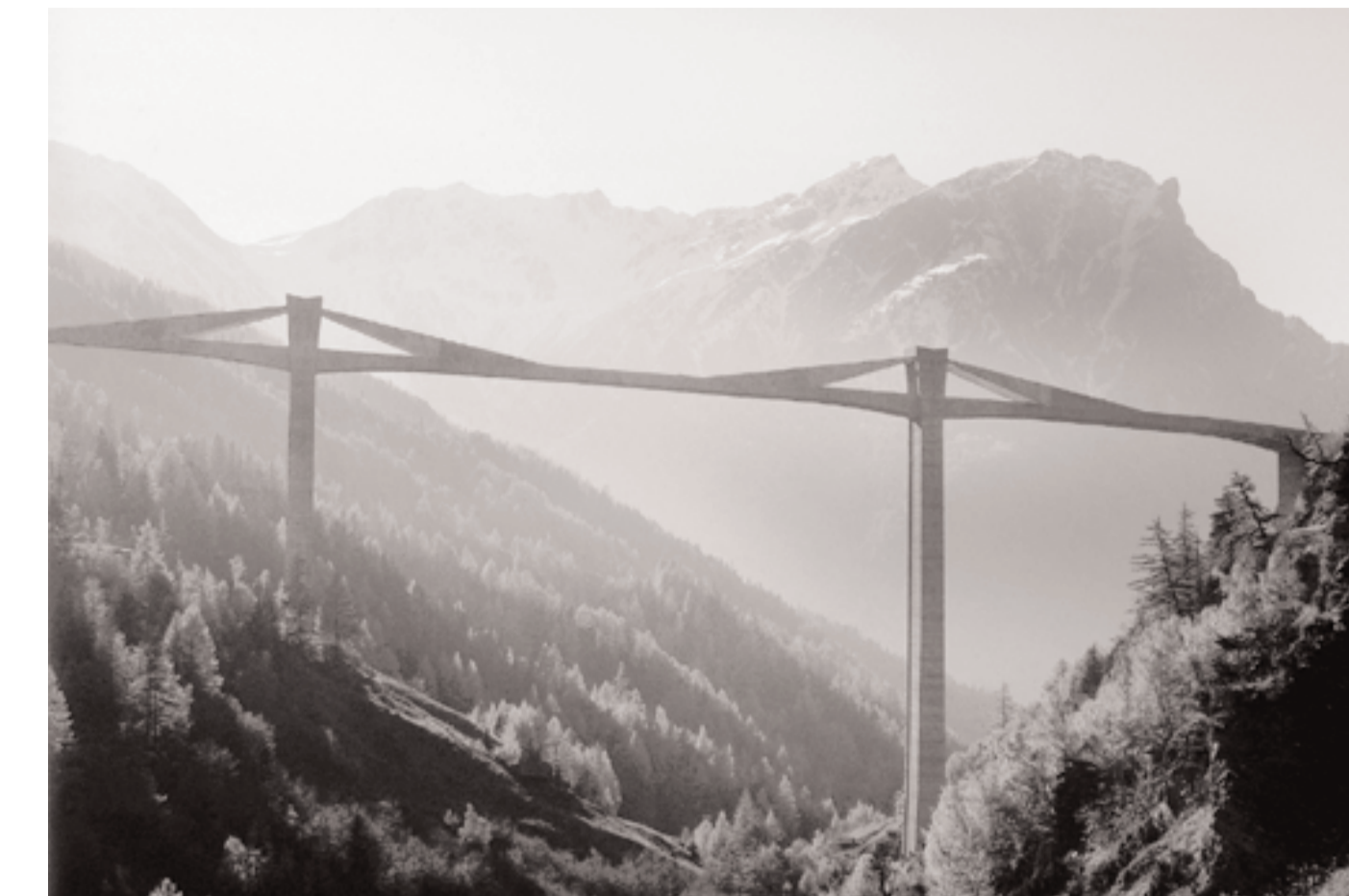
Ganterbrücke der Simplonstrasse, 1980, erbaut von Christian Menn, der zu den wichtigsten Schweizer Bauingenieuren gehört. zvg
